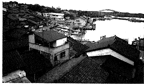
写真-3 相川町姫津(平成14年)
