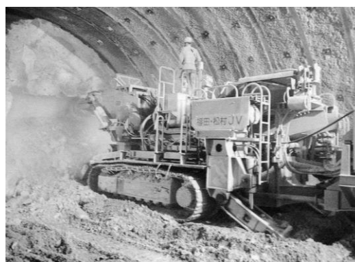
写真 1.2 機械掘削（自由断面掘削機）
