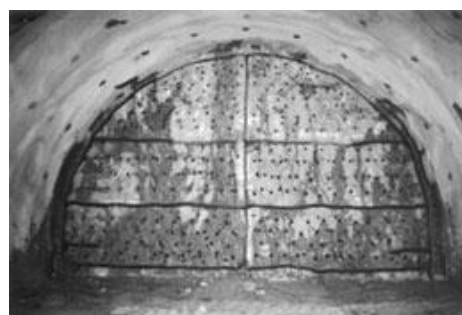
写真 1.3 割岩工法による掘削状況 14)
