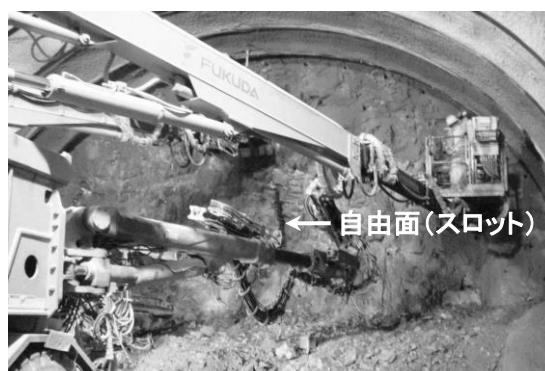
写真 1.4 自由面発破のための自由面（スロット）形成状況
