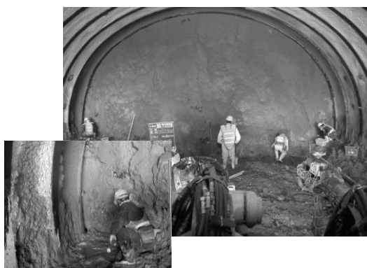
写真 1.1 発破掘削（爆薬装填状況）
