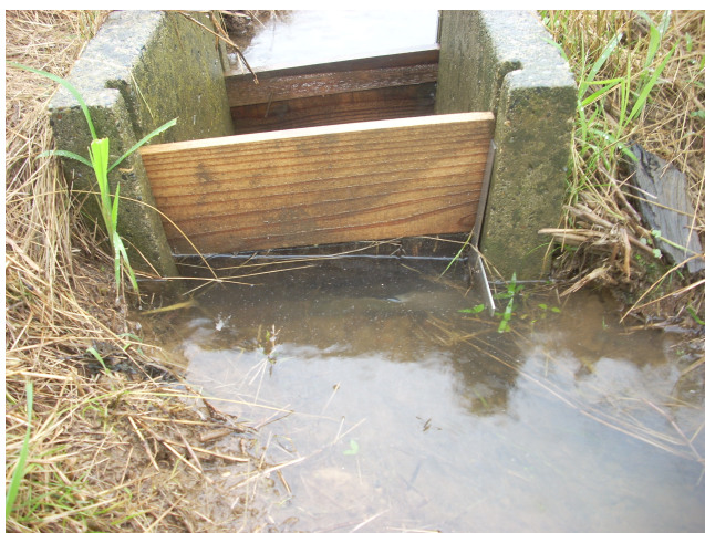
図 2.4 落水量調整金具（新潟市白根郷地区）
