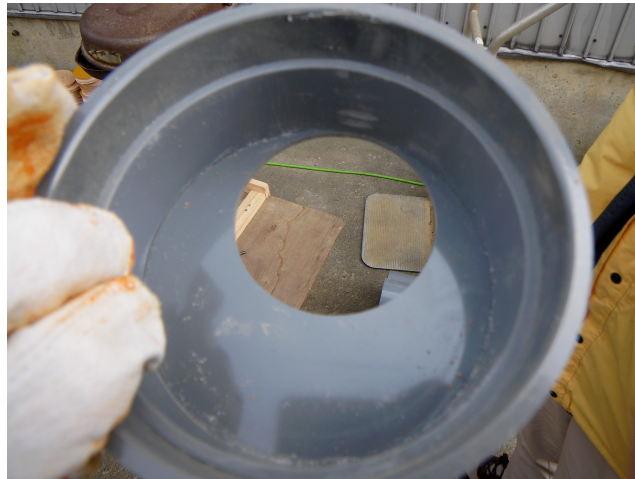
図 2.5 落水量調整キャップ（新潟市横江地区）
