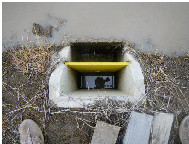
写真 2.2 垂直設置型落水量調整板（長岡市深沢地区，上越市三和地区）
