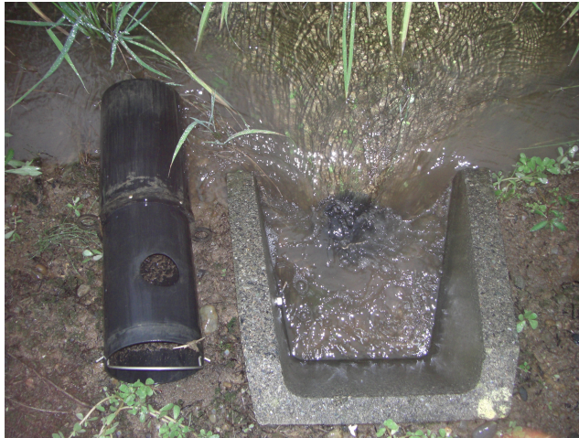
図 2.3 機能一体型フリードレーン調整管（見附市貝喰川地区）
