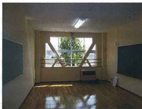
写真 4.8 桁行方向鉄骨ブレース増設(補強後)
