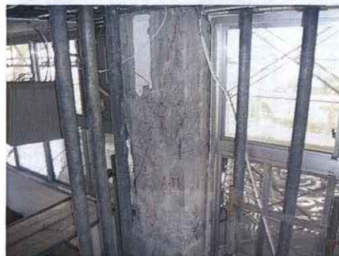
写真4.2 1階柱 A-11 (はつり後)
