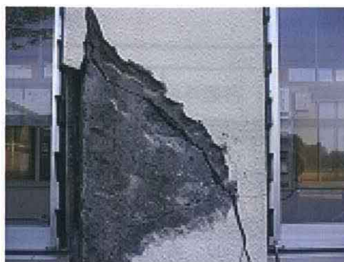
写真 3.2 1階柱 C-10 (はつり後)
