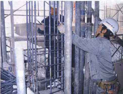
写真4.3 1階柱 A-11 (主筋溶接)
