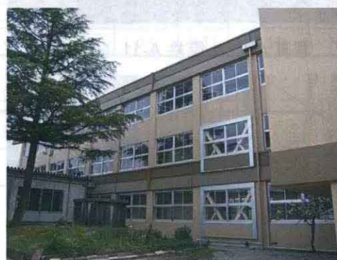
写真 4.12 北側外観写真(補強後)
