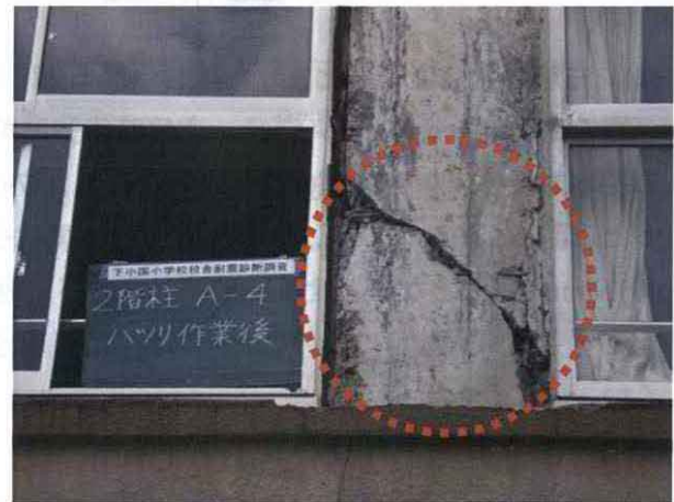
写真 5.2 2 階 A-4 柱のせん断ひび割れ
