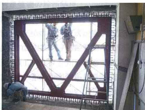
写真 4.7 桁行方向鉄骨ブレース増設
