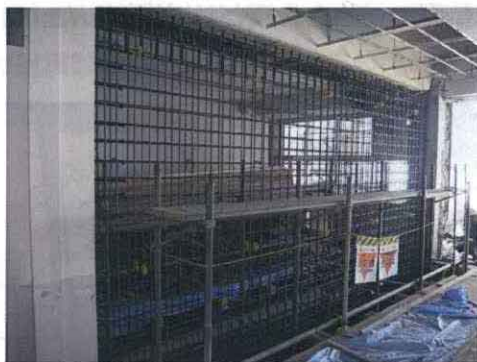
写真 4.9 梁間方向 RC 造耐震壁増設
