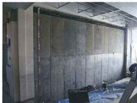
写真 4.10 梁間方向 RC 造耐震壁増設(補強後)
