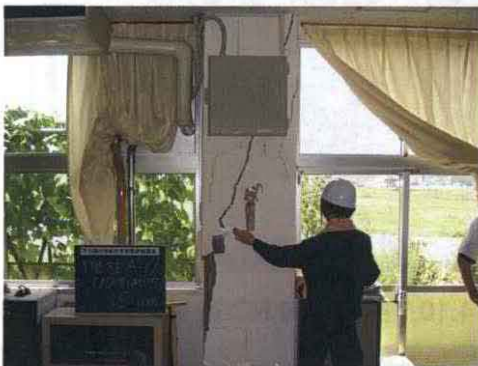
写真4.1 1階柱 A-11 (はつり前)
