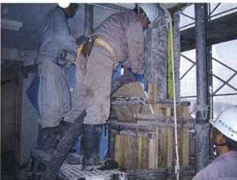
写真4.5 1階柱 A-11 (コンクリート打ち直し)
