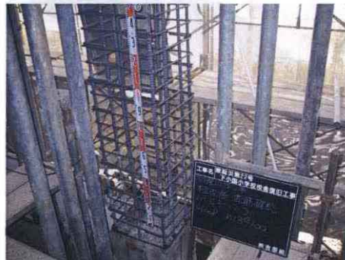
写真4.4 1階柱 A-11 (帯筋取り付け)
