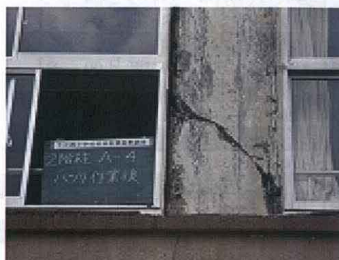
写真 3.4 2階柱 A-4 (はつり後)
