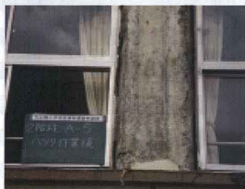
写真 3.6 2階柱 A-5 (はつり後)
