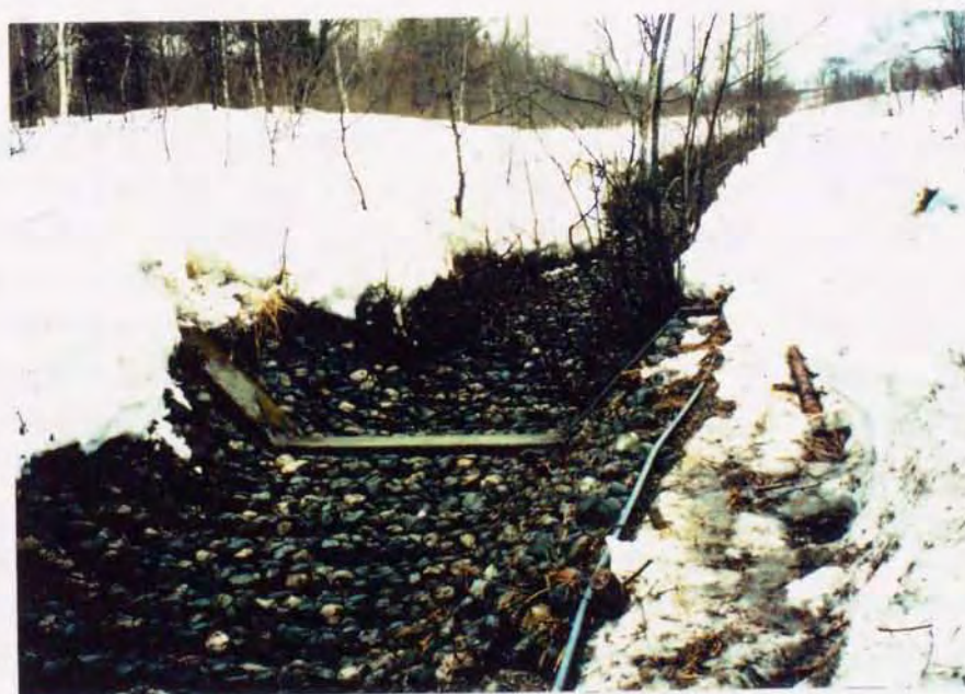
図 6 - 2 長野県栂池スキー場・から沢の雪泥流発生域の蛇籠
