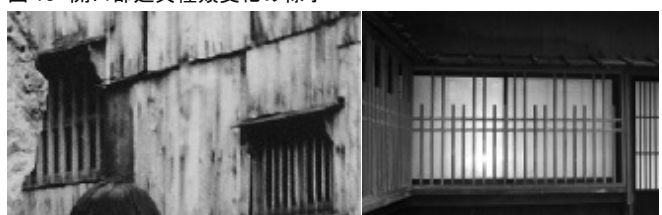
写真1 事業以前の簡素な格子 注4) 写真2 事業後の格子
