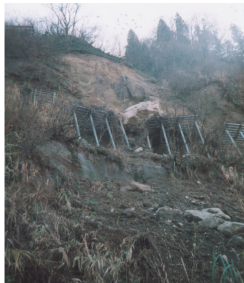
写真5 落石により雪崩予防機能低下 (十日町市中条)
