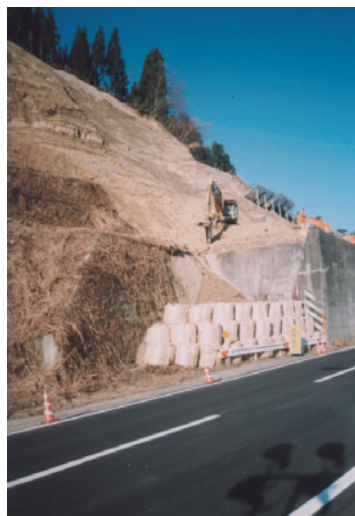
写真6～8 泥岩等の風化により雪崩予防基礎部分の 支持地盤が崩落した(十日町市焼野)
