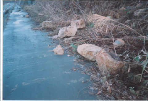
写真3, 4 信濃川左岸に分布している 堆積層が予防柵ポケットや歩道に落下 (小千谷市山本)
