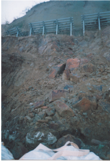
写真3, 4 信濃川左岸に分布している 堆積層が予防柵ポケットや歩道に落下 (小千谷市山本)
