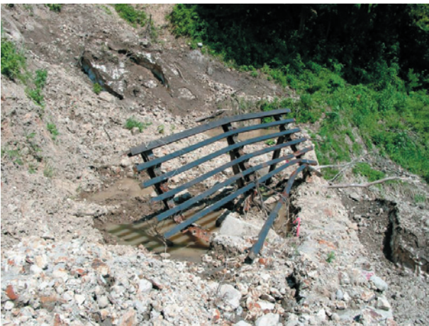
写真2 破損した雪崩予防柵 (長岡市濁沢町 2005年5月26日撮影)
