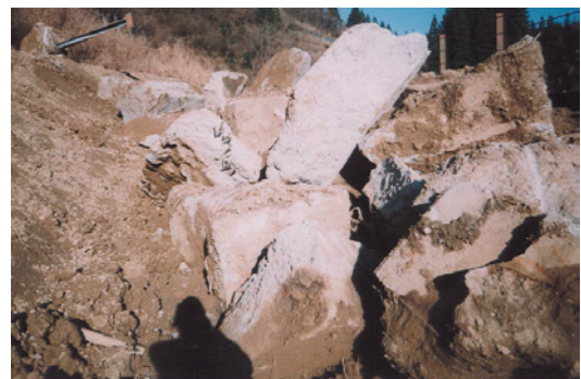
写真6～8 泥岩等の風化により雪崩予防基礎部分の 支持地盤が崩落した(十日町市焼野)
