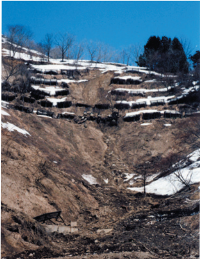
写真1 流出した雪崩予防柵 (長岡市濁沢町 2005年4月9日撮影)
