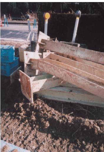
写真2 破損した雪崩予防柵 (長岡市濁沢町 2005年5月26日撮影)
