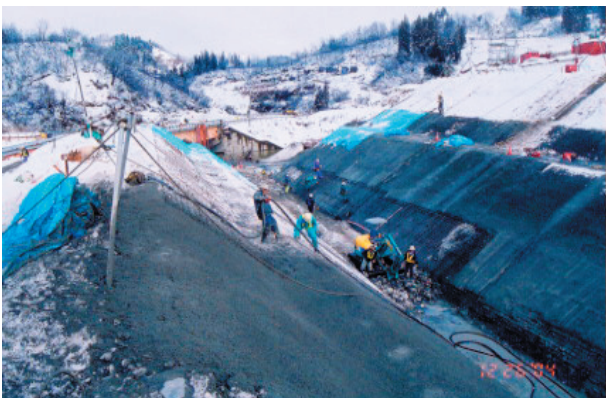
写真-7 融雪水量を考慮した断面を有する仮排水路
