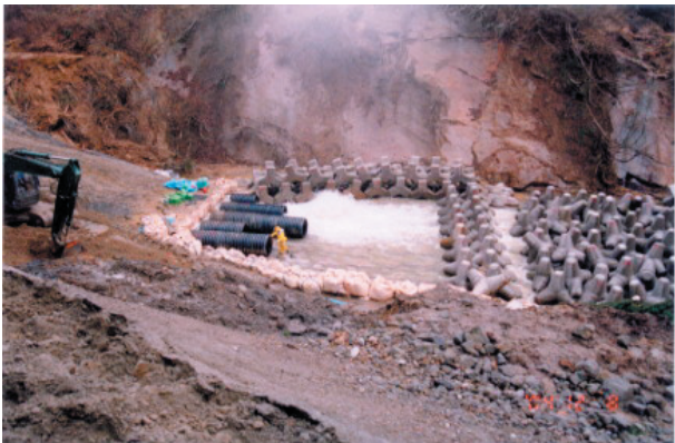
写真-6 埋設管路による代替排水路（排水口付近の状況）
