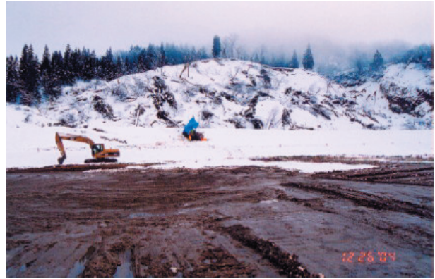
写真-8 東竹沢地すべり頭部排土工（ほぼ施工完了時の状況、正面は主滑落崖。）
