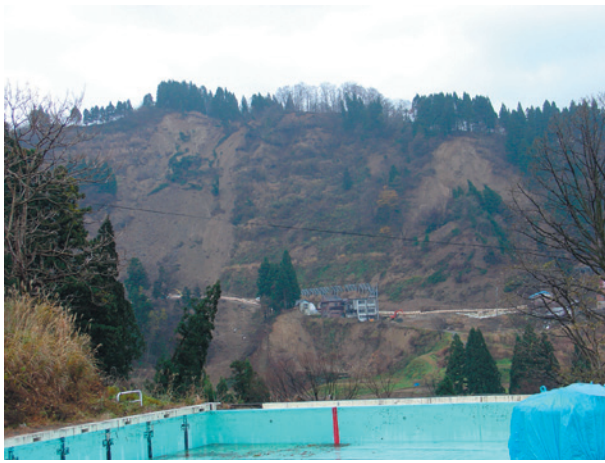
写真 15. 羽黒トンネル西坑口脇の崩壊（向かって左）と南側に隣接する地すべり（向かって右）
