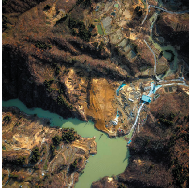
写真4. 東竹沢の地すべりによる河道閉塞(11月26日、アジア航測(株)撮影)
