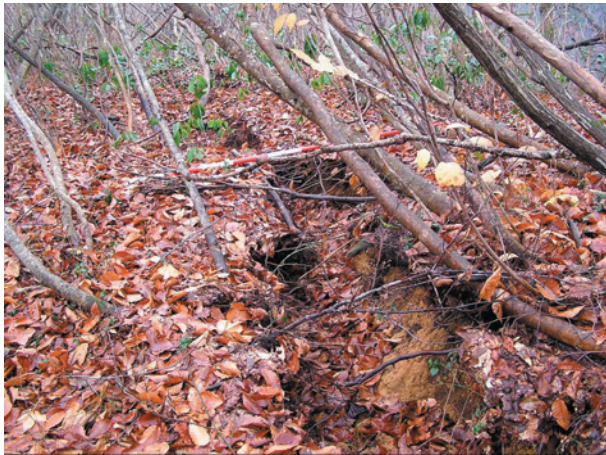
写真7. 地すべり頭部に見られる開口亀裂（東竹沢）
