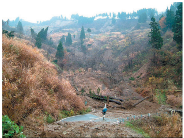
写真 17. 朝日川左支三石川上流の地すべり
