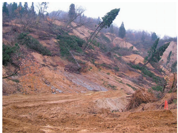
写真5. 地すべりの滑落崖とすべり面(東竹沢)
