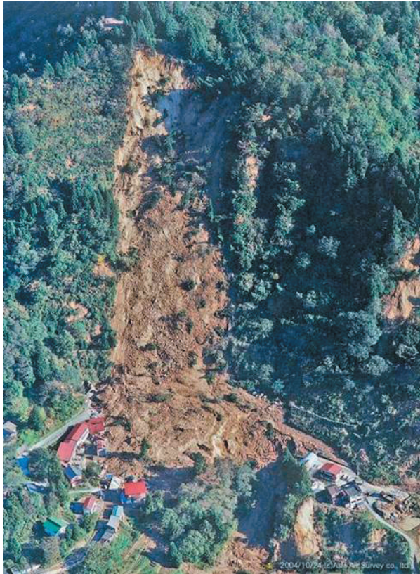
写真 14. 羽黒トンネル西坑口付近の崩壊（アジア航測（株）撮影）
