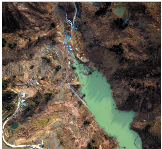
写真11. 寺野地区の河道閉塞（11月26日、アジア航測（株）撮影）
