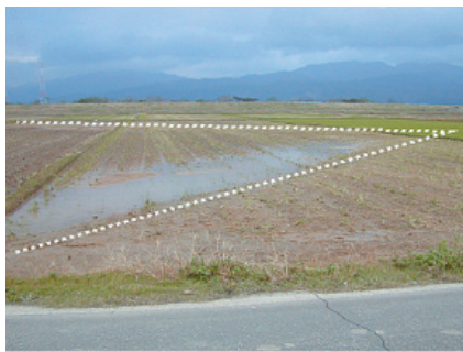
図11 広範囲にわたる陥没 連続する段差・亀裂により、広い範囲で陥没が生じている。陥没した所は水がたまっている。
