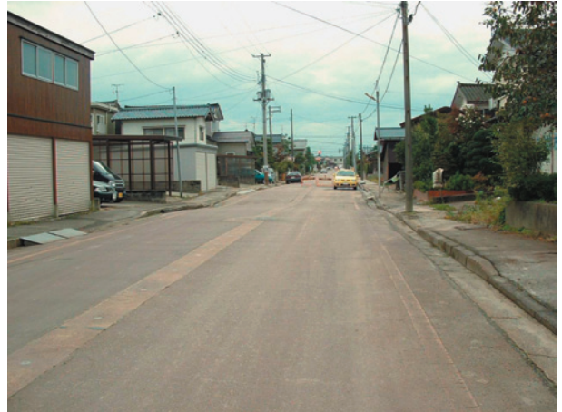
第6図.液状化により波打った道路(南本町2丁目)
