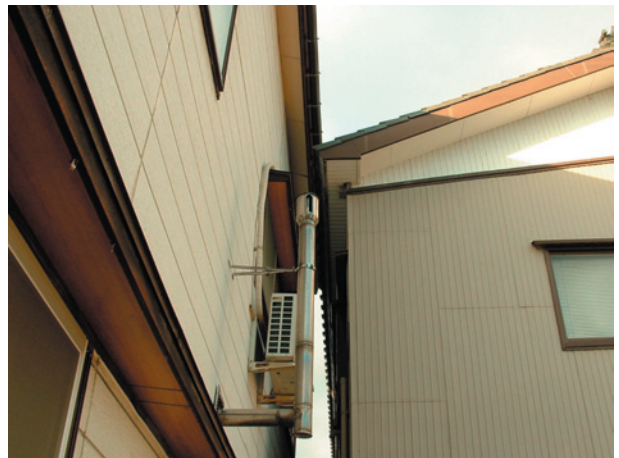
第7図.噴砂が原因で傾き接触した家屋(南本町3丁目)
