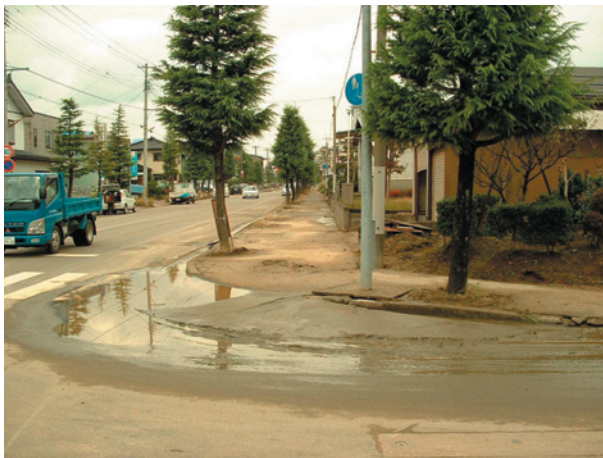
第4図.舗装の境界からの噴砂(南本町2丁目)
