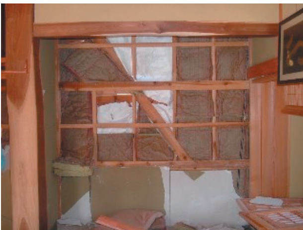
写真.8 片筋かいをもつ石膏ボードの壁
