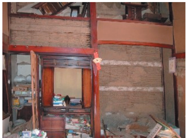
写真.9 筋かいのない土壁
