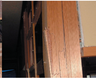
写真.16 柱の折損
