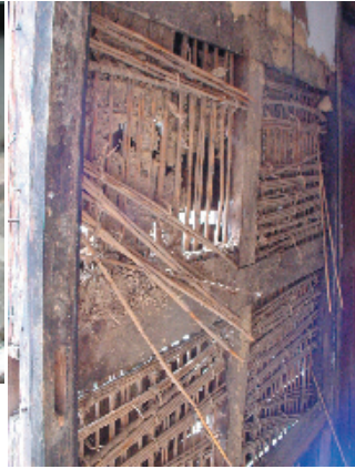
写真.25 土塗壁の崩落 (No.1)
