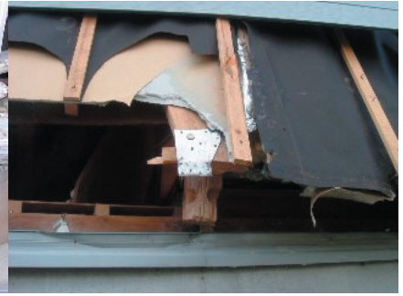
写真.14 筋かいプレートの使用例 (土台や柱が割裂している)
