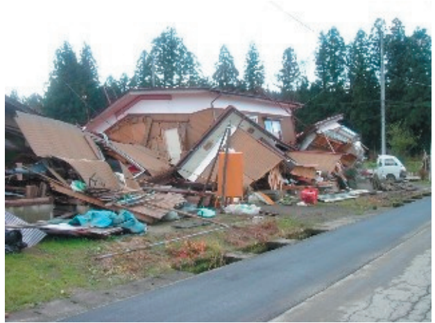
写真.3 在来軸組住宅の倒壊状況
