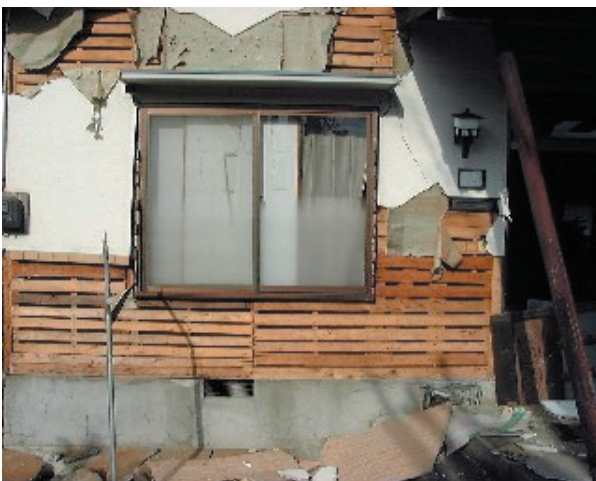
写真.10 外壁の剥落
