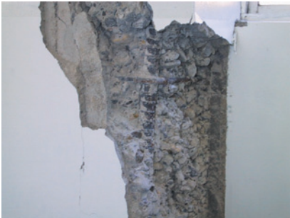
写真22 写真21の詳細(ジャンカが認められる)
