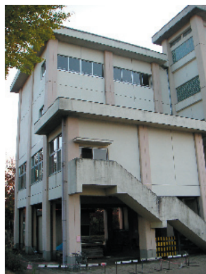
写真5 小千谷市立東小千谷中学校(増築棟)
