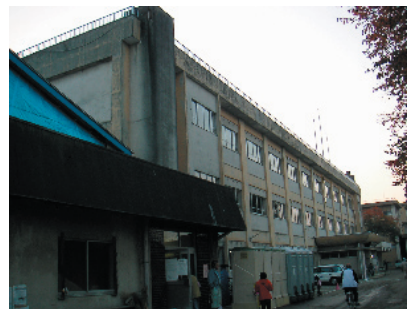
写真3 小千谷市立東小千谷小学校(北棟)
