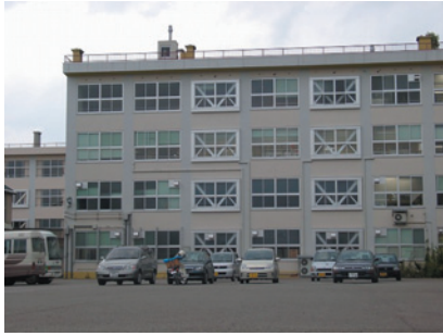
写真7 十日町高校第2棟（RC4F, 補強済み）の北面の外観。被害は軽微
