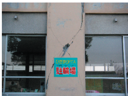
写真4 東小千谷小学校(北棟)の1階の柱
