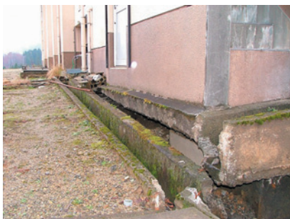
写真16 校舎棟の南西隅角部から北側をみる。向こうが体育館棟。校舎棟は体育館棟に比べ建物の傾斜が大きく。この部分の建物の不同沈下および地盤の沈下が最も大きい。
