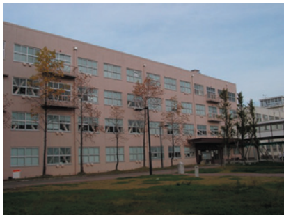
写真10 長岡高専4号館はKブレースにより補強がされていた
