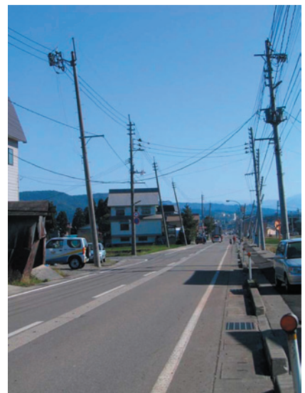
(6) 電柱の傾動
