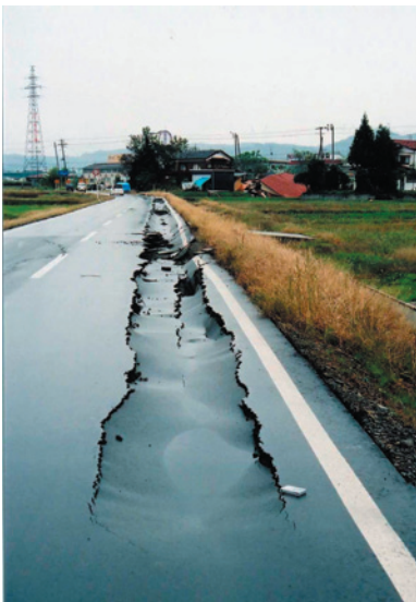
(4) 填砂・陥没
