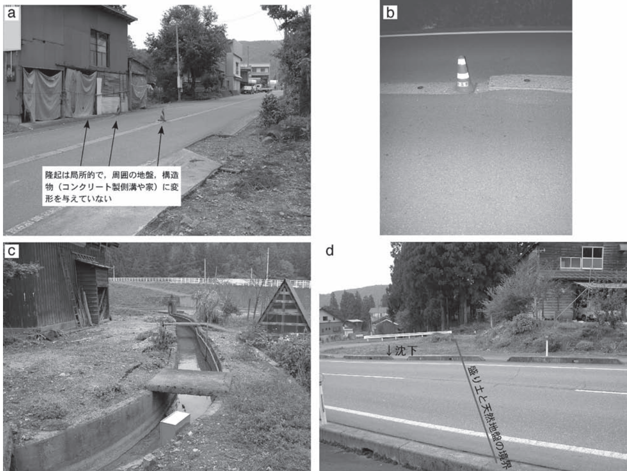
図10 小平尾断層周辺の地表変状（魚沼市旧広神村小平尾地区）。a：アスファルト舗装の端部と消雪パイプ設置のコンクリート部のみの隆起。他の部分には変状はない。b：消雪パイプ設置のコンクリート部のみ隆起。c：小平尾断層にほぼ平行（北東－南西）な地震時に形成された開口亀裂（盛り土の南東端）。d：国道352号線の盛り土と天然地盤の境界部における不同沈下。
