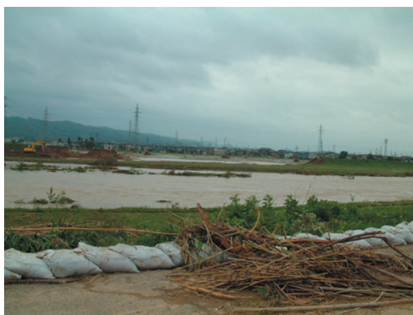
写真2 諏訪地点の破堤状況（7・14 右岸堤防上から大熊撮影）
