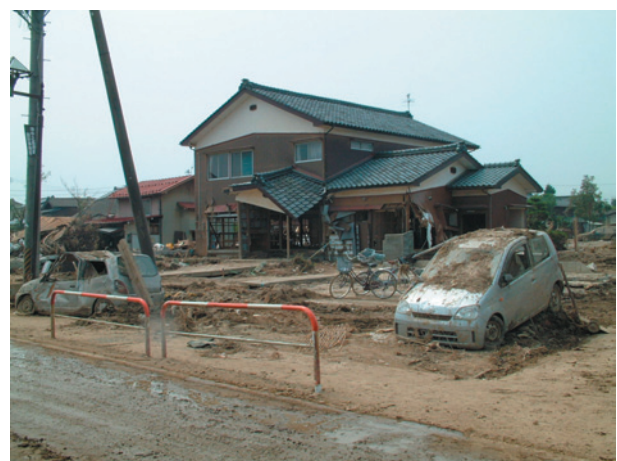
写真1 中之島破堤地点の家屋の破壊状況（7・25・大熊撮影）
