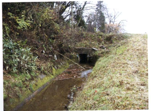
写真2 下流端の樋門
