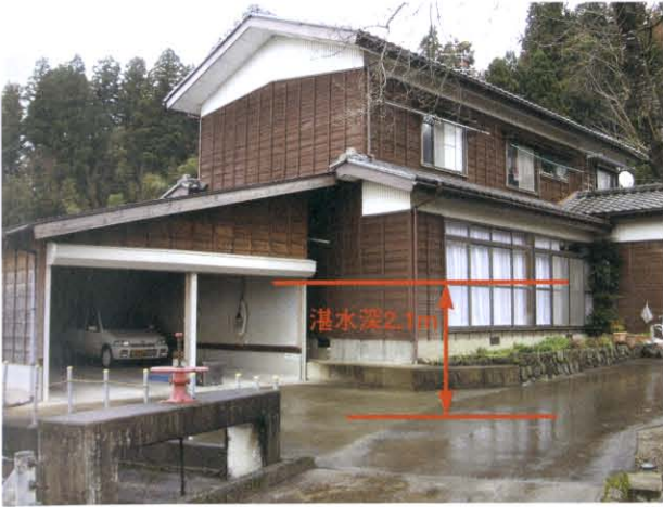
写真3 家屋の浸水状況
