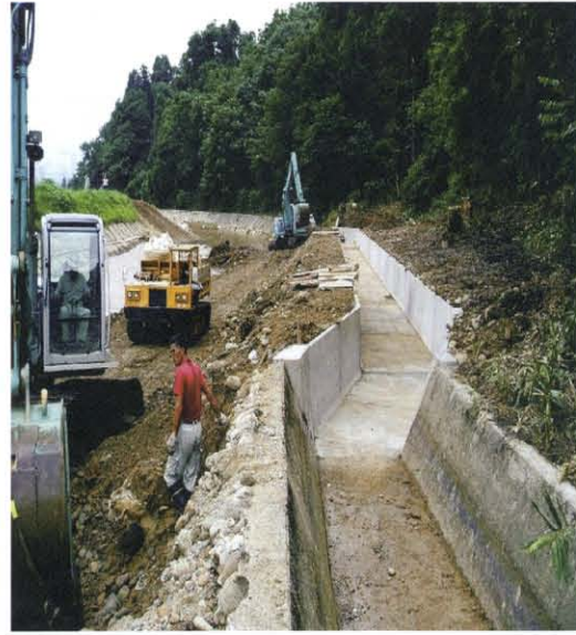
写真12 崩壊した用水路の復旧作業現場（下田村） （写真提供：三条農地事務所）
