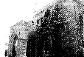
図12 和洋館並列住宅
