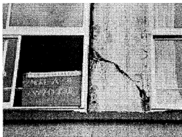
写真-4 2階柱A-4 (はつり後)
