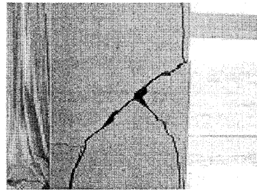
写真-7 2階柱A-4 (内観写真)
