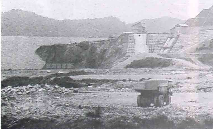
ダム建設(下田村大江) 1991. 7. 1
