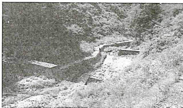
写真3. 蛇籠で護岸された砂防ダム（新発田市荒川川）
