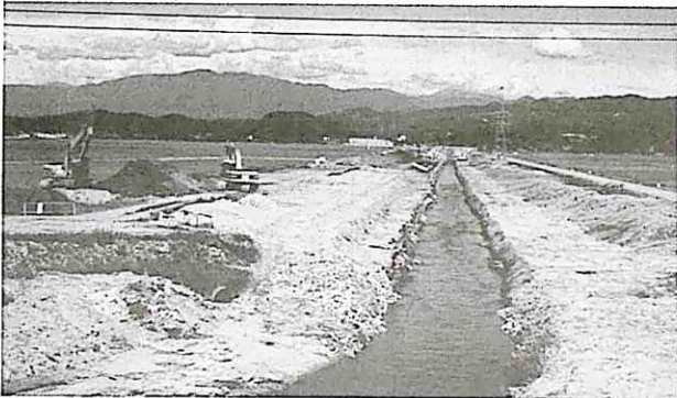
写真9. 全ての生物が失われた多自然型河川工法の現場(月岡荒川)
