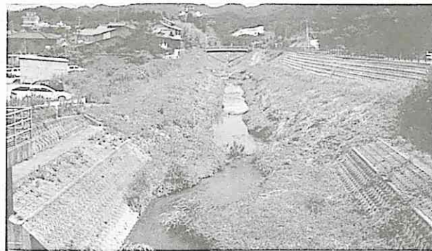
写真5. コンクリートで護岸されて川幅が狭く、穏やかに蛇行して流れる水（月岡小烏川）
