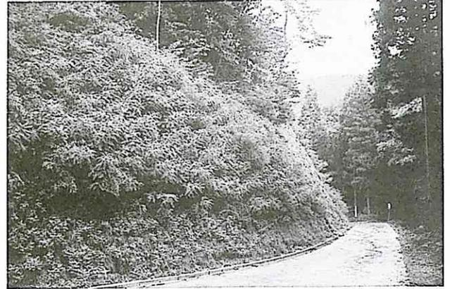
写真1. 人通りがほとんどない山道だが、舗装されて、斜面にはイタチハギとヨモギの仲間が吹き付けられている（両津市 2001. 8. 26）
