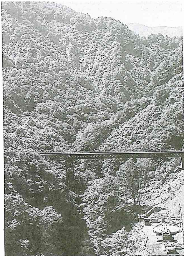
ダム建設現場 2003 7 6
