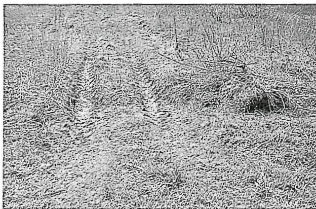
写真2 つぶれた配水管付近（2004. 4. 13撮影）
