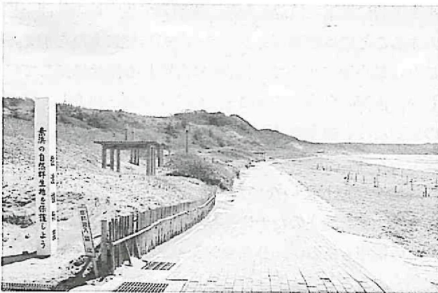
写真1 「歩道の設置」貴重な砂丘植生の中に歩道の設置
