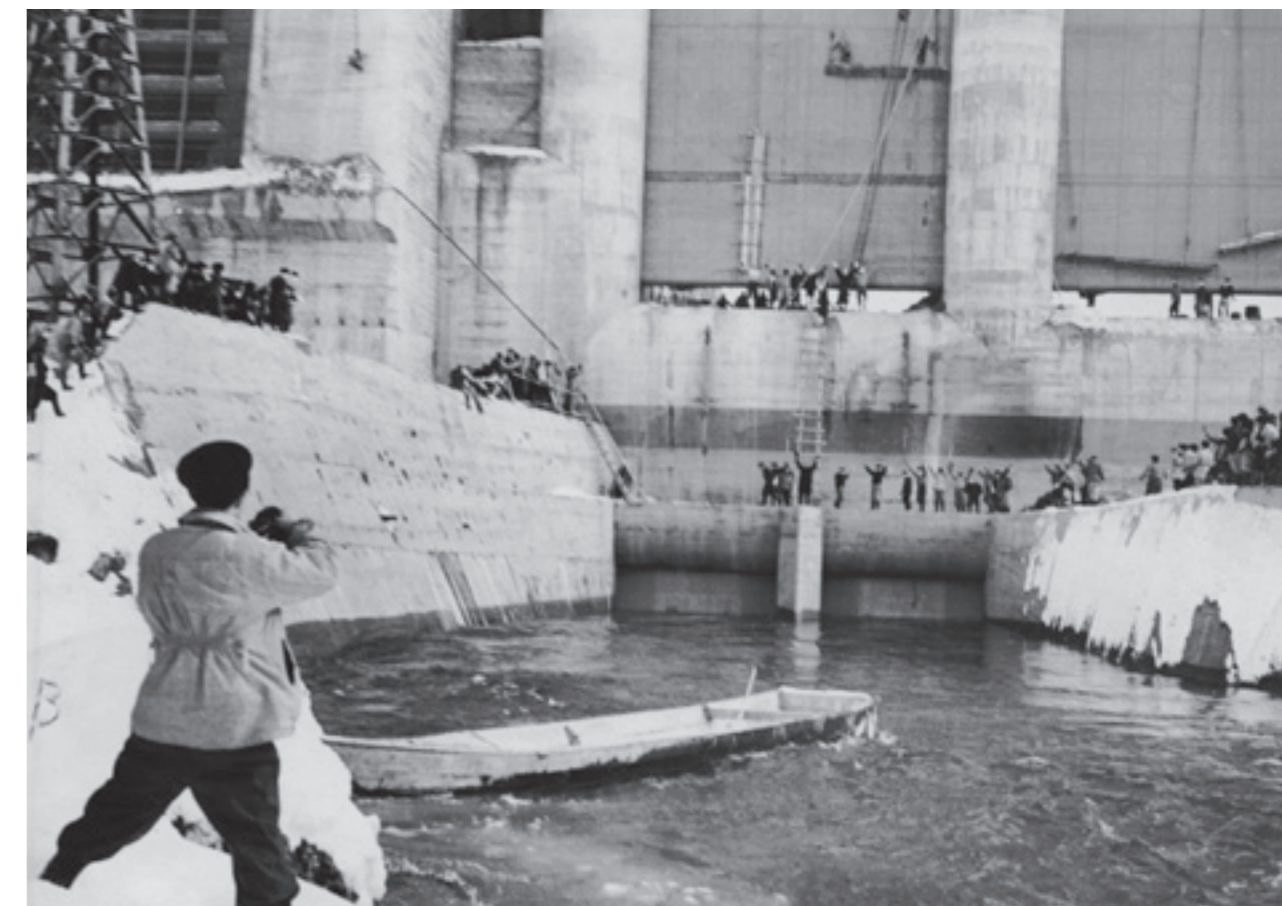
只見川上田発電所での仮排水路閉塞完了と湛水開始 この後、上流の中川・宮崎集落では、水没した田畑の代わりに上野原開拓に乗り出すこととなった 金山町・上田 1954年2月4日午前10時
