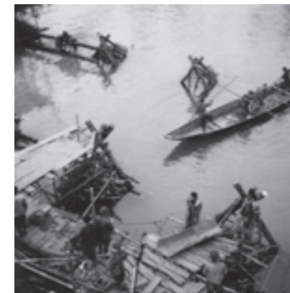
上田発電所 嶽の山中腹より工事場を望む 金山町・上田 1953年 / 上田発電所工事現場 金山町・上田 1952年～1954年 / 上田発電所工事現場 金山町・上田 1952年～1954年
