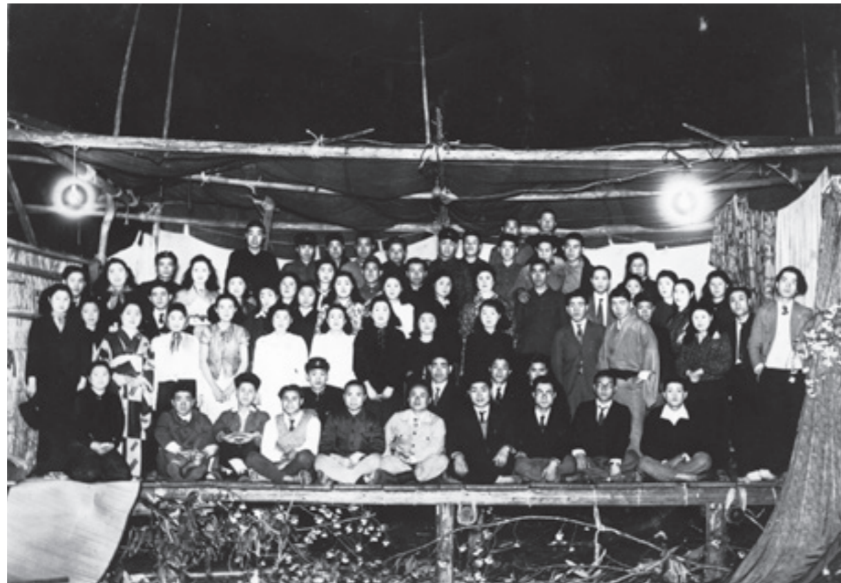
農村歌舞伎の伝統を引き継ぐ、細木で組み立てられた仮設舞台の上の青年団員 金山町・川口 1949年
