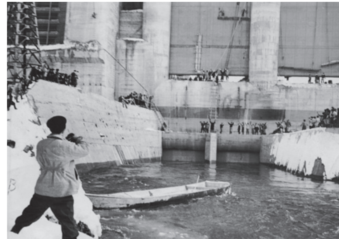
只見川上田発電所での仮排水路閉塞完了と湛水開始 この後、上流の中川・宮崎集落では、水没した田畑の代わりに上野原開拓に乗り出すこととなった 金山町・上田 1954年2月4日午前10時
