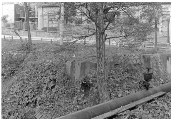
図4 石神井川第1橋脚後
