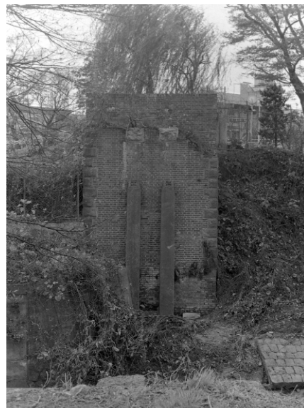
図5 石神井川第2橋脚後
