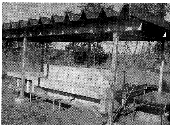
写真3 屋根がかけられ完成した洗い場
