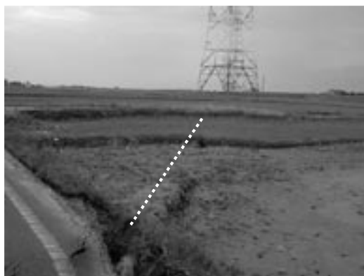
図-6 連続する段差・亀裂① 図中の破線で示すように，段差・亀裂は農道を横断して鉄塔の方向へ連続している。
