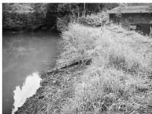
(a) 健全なため池215-379
