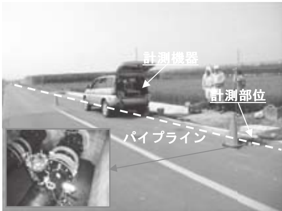
図10 実構造物での AE 計測状況
