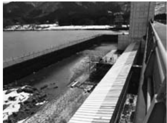
図1 河床砂礫を採取した頭首工のゲート上流部の仮縮切り内ヤード
