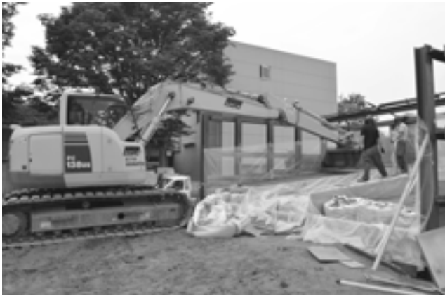
図5 法面バケットを用いたCB層の試験施工
