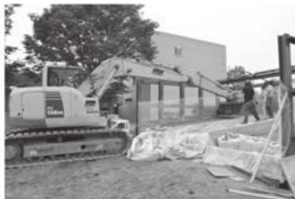
図7 法面バケットによるキャピラリーバリア土層の試験施工
