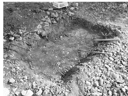
(c) 埋戻し・センサーの設置
