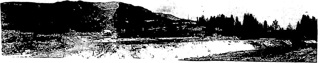
写真-5 大倉地すべり地
