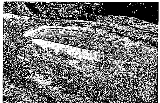
写真-4 濁沢地すべり地における池の底面の冠頭部へ向かっての転倒—池の手前の縁辺に平行正断層が発生している— Photo.4 Inclined bottom plain of the pond at Nigorisawa — the parallel normal fault is developed at the marginal side of the pond—
