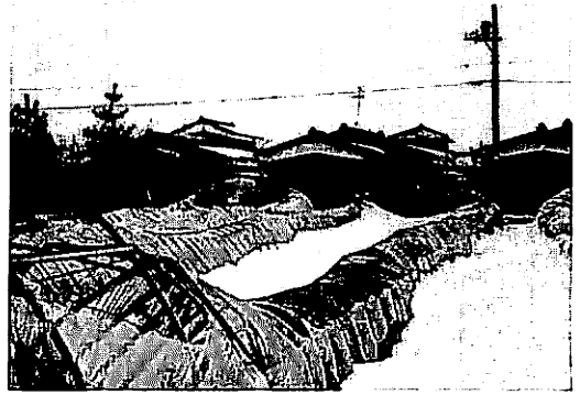
写真-3 積雪によるパイプハウスの損壊状況 (新潟市農林課撮影)
