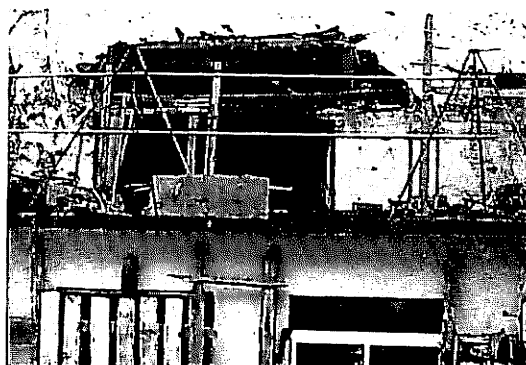
写真-3 被災した苗場館
