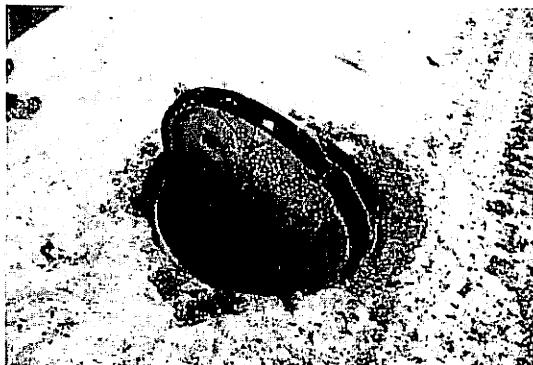
写真-1 凍着凍上によるマンホールの浮き上がり（長野県蓼科高原）
