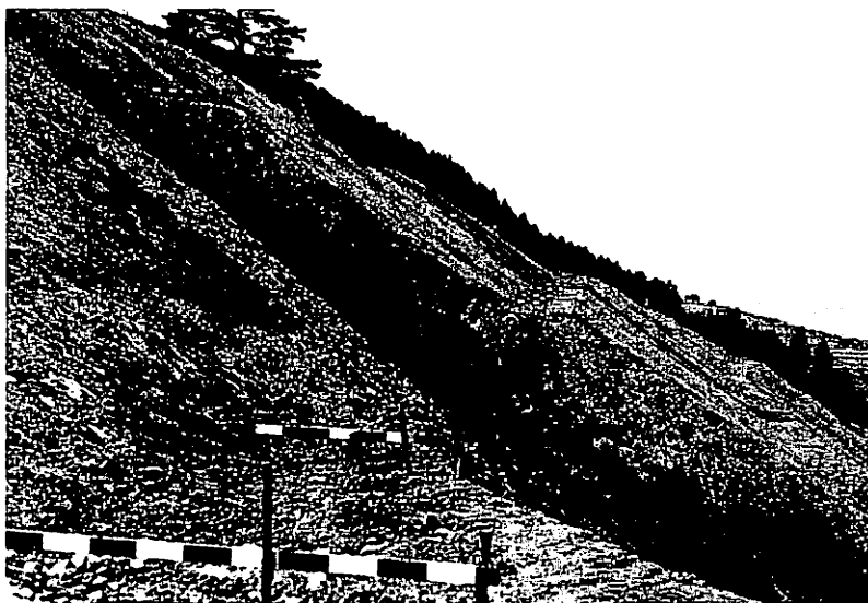
写真-6 地すべり後のカット面に生じた新しい地すべり Photo. 6 Recent small landslide occurred after excavation
