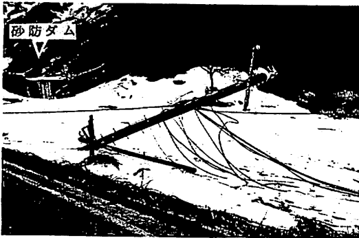
写真-2 コンクリート電柱の倒壊状況 (1986年4月29日撮影)
