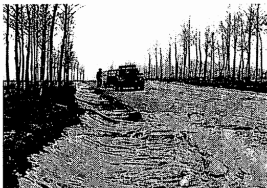
写真-1 依蘭県付近の雪の吹き溜り常習地 (12月15日)
