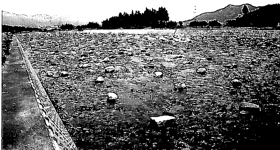
写真－ 9 登川流路工下流部 人工的に置いた自然石の配置が不自然である。
