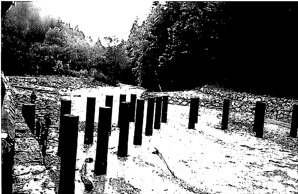
写真-2 ラインバッハ溪流に設置された流木阻止構造物
