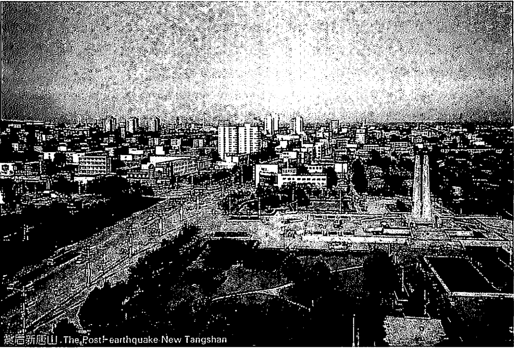
図-3 唐山地震の被害をのりこえ、近代都市として復興した唐山市
