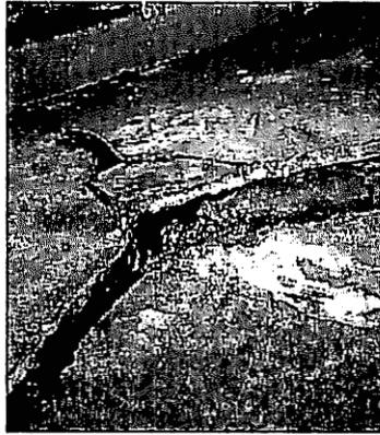
写真-11 海岸緑りの擁壁ではこうした亀裂が多く確認
