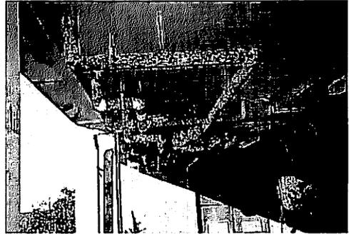
写真-4 腐食した鉄筋が露出
