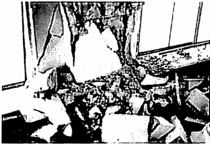
写真-2 被災した鹿島台病院の内部
